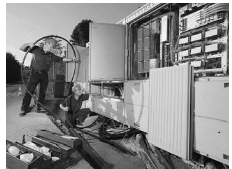
Techniker der Deutschen Telekom bauen das Breitbandnetz aus. Foto: Deutsche Telekom
